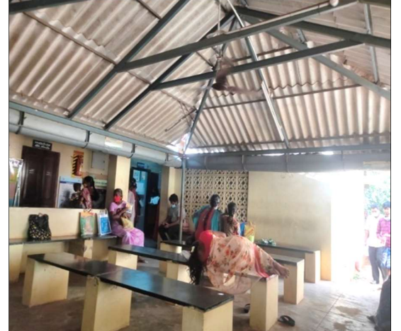
விளக்கப்படம் 3.8: மொடக்குறிச்சி நகர்ப்புற PHCல் கல்நாற் தாளின் (asbestos sheet) கீழ் இயங்கும் OP செயலறைகள்
